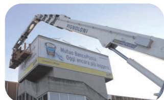
Montaggi grandi strutture
